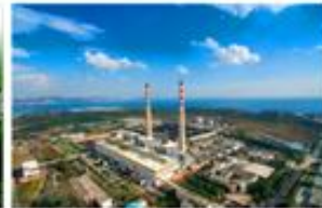
大连甘井电子气检测项目
